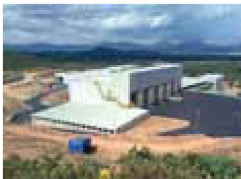
L'impianto servito da Abbanoa
