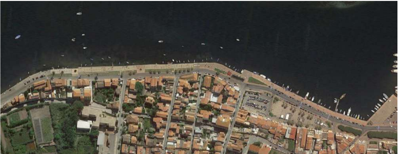
Fig. 165. Lungomare Cristoforo Colombo – vista aerea
