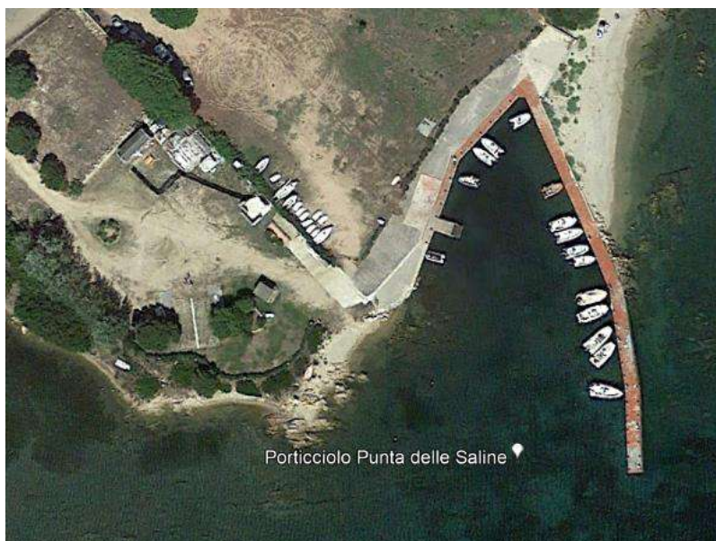
Fig. 75. Porticciolo Punta delle Saline – vista aerea
