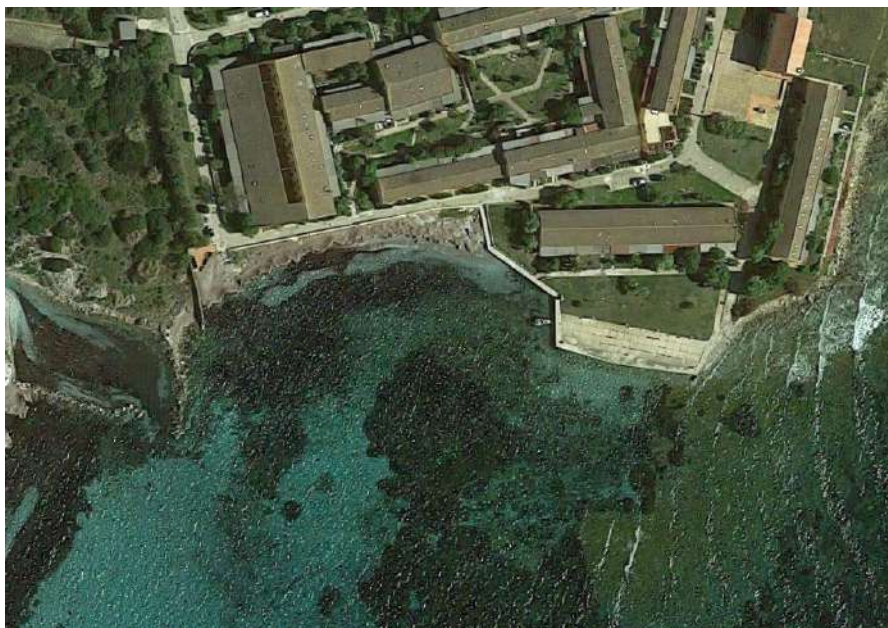
Fig. 229. Spiaggetta Torre delle Saline – vista aerea
