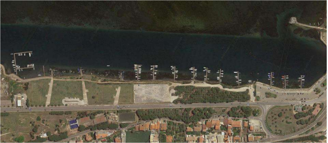
Fig. 164. Lungomare Nassiria – vista aerea
