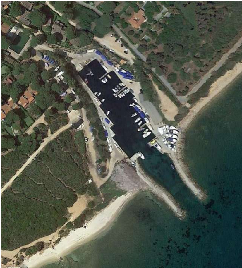
Fig. 149. Calaverde – vista aerea
