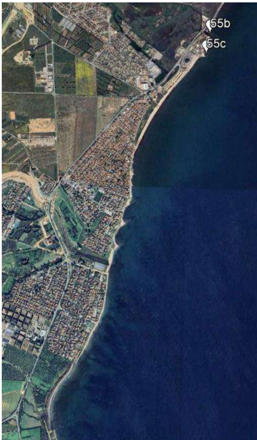
Fig. 141. Infrastrutture nel Comune di Capoterra – ubicazione sulla costa.
