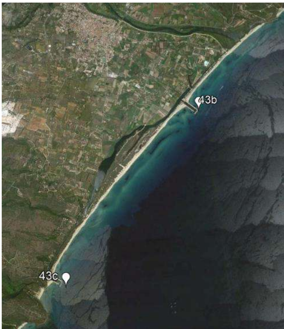
Fig. 104. Infrastrutture nel Comune di Orosei – ubicazione sulla costa.
