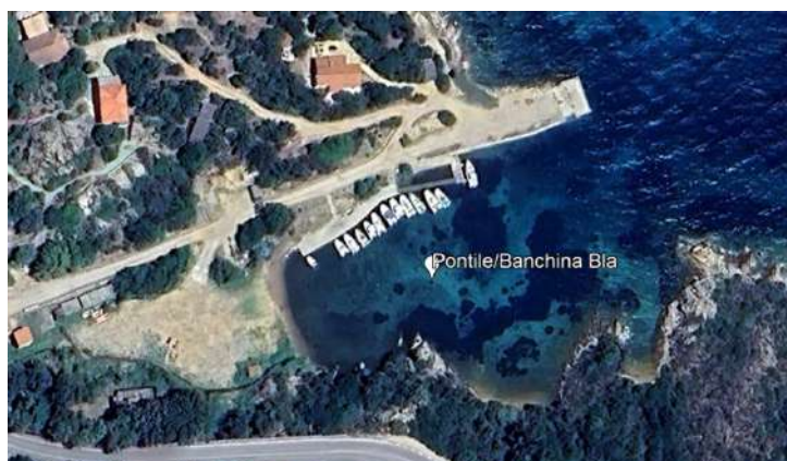
Fig. 40. Pontili Bla – vista aerea
