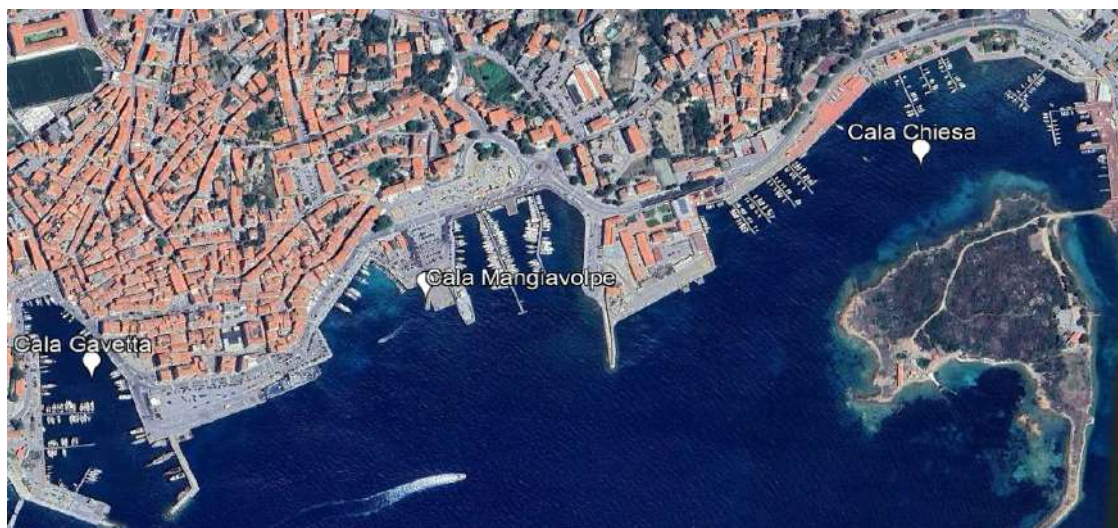
Fig. 17. Cala Gavetta, Cala Mangiavolpe, Cala Chiesa – vista aerea
