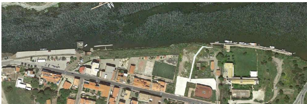
Fig. 213. Banchine 1 e 2 – vista aerea
