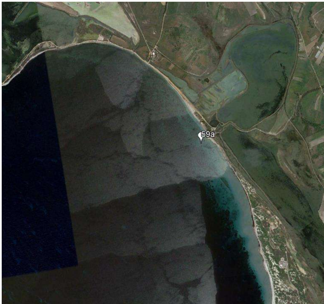
Fig. 157. Infrastrutture nel Comune di Giba – ubicazione sulla costa.
