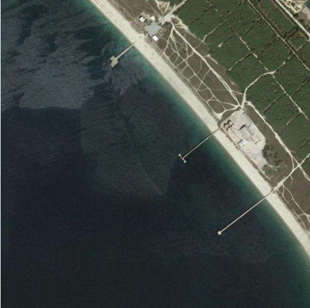
Fig. 200. Pontili spiaggia di Torregrande – vista aerea
