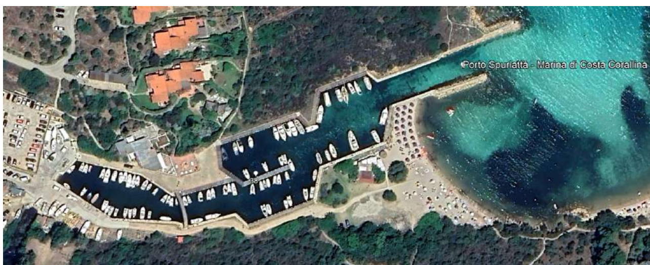
Fig. 78. Porto Spurlatta - Marina di Costa Corallina – vista aerea
