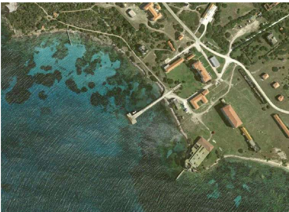
Fig. 235. Asinara Pontile di Cala Reale – vista aerea
