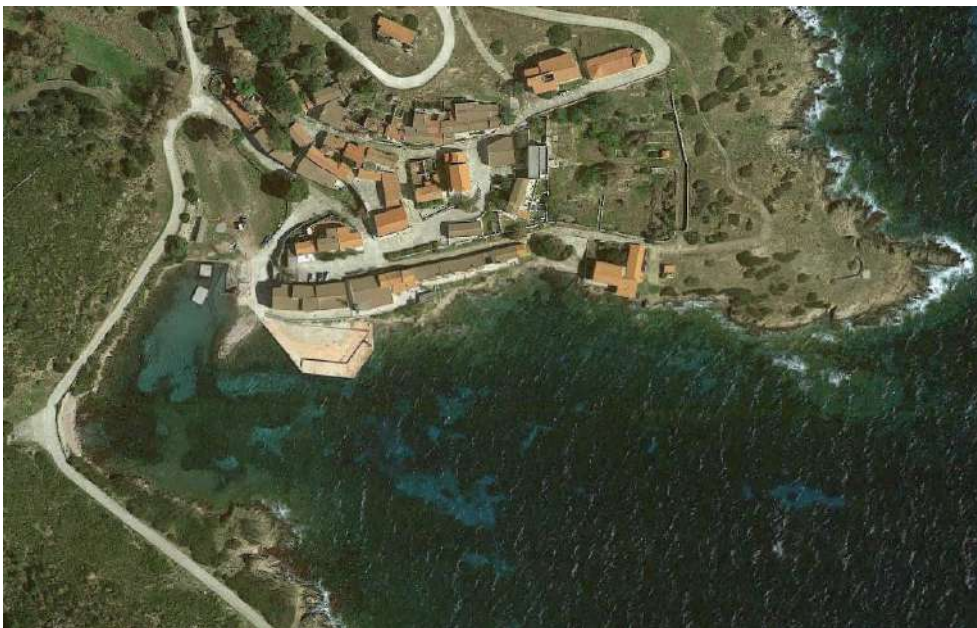
Fig. 234. Asinara Molo Cala d'Oliva – vista aerea
