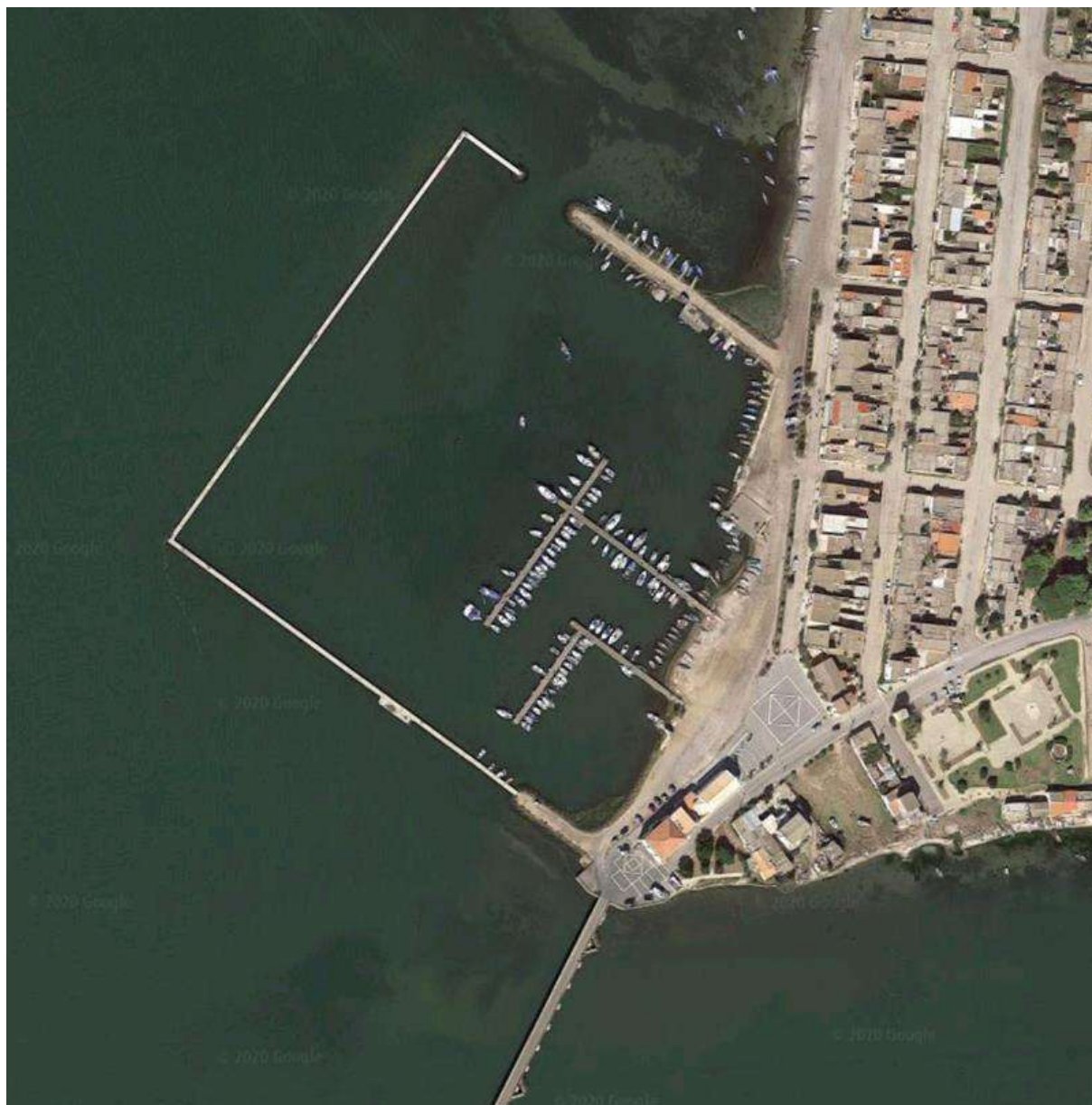
Fig. 193. Marceddì – vista aerea.
